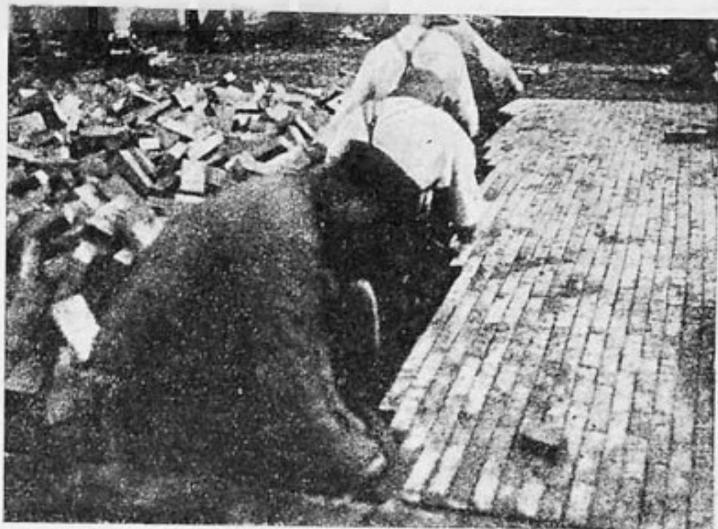
Укладывают клинкер.
